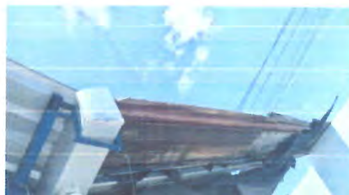
Foto 2: CUBIERTA DE LAMINA Sustitución de cubierta de techo con lámina galvanizada, Tipo de lamina: troquelada Calibre: 26, incluye: fijaciones y sellado en traslapes. Patio de abajo, patio arriba y a la par de cocina
