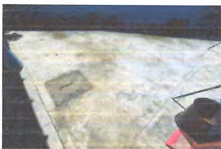
Foto 3: PISO Sustitución de piso de concreto con acabado liso por piso de granito, incluyendo preparación de superficie y nivelación. Patio de abajo, patio arriba
