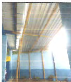
Foto 1: ESTRUCTURA DE TECHOS Sustitución de estructura bambu por estructura metalica para soporte de cubierta de lámina incluyendo perfiles para vigas, travesaños, sujeta con tornilleria; corte, soldadura y anclaje de la estructura portante. Patio de abajo, patio arriba y a la par de cocina
